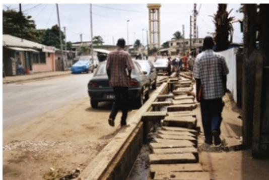
Photo - Nettoyage de canalisations obstruées par des déchets solides (terre, végétaux, etc.). Quartier Sotéga, Libreville. Cliché Corine Ada Nzougbe, août 2004.
